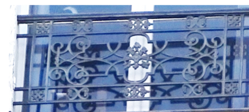
Catalogue Val d'Osne Barbezat (Haute-Marne), 1860. Garde-corps, reconnaissable dans le tableau à droite, toujours visible au 19, quai Saint-Michel. Photo : François Jacquesson.
