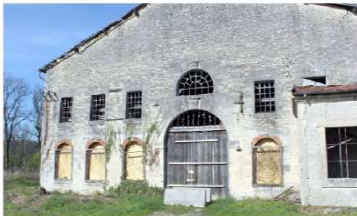
L'usine du Rongeant date de 1835. Photo: Roland Deupit
